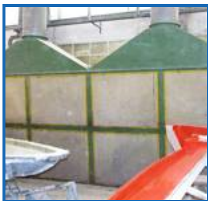
▲ Foto 3 - Esempio di sistema di captazione laterale
