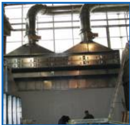
▲ Foto 1 - Esempio di sistema di captazione superiore
